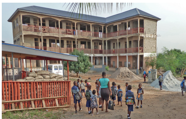
L'école en phase de construction.
