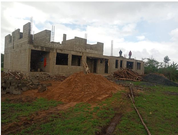
Construction d'une maison d'accueil
