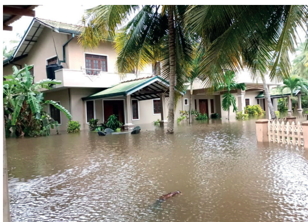
Das Bildungshaus, das von den Überschwemmungen betroffen ist
