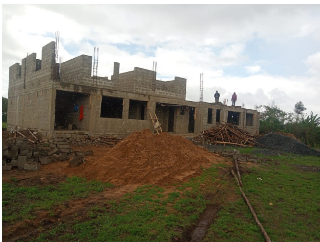
Bau eines Heimes
