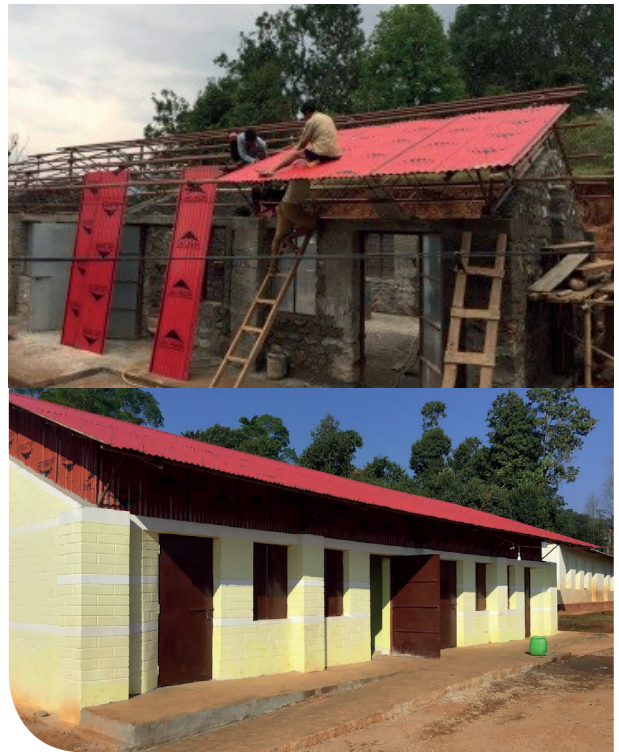
De bouw van twee nieuwe klaslokalen
