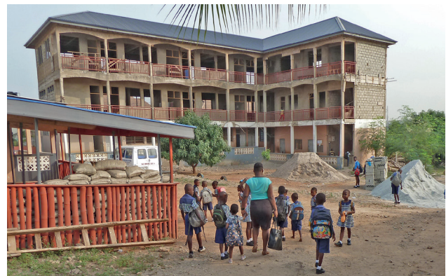
De school in de opbouwfase.
