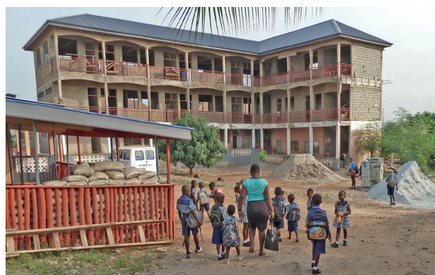
De school in de opbouwfase.
