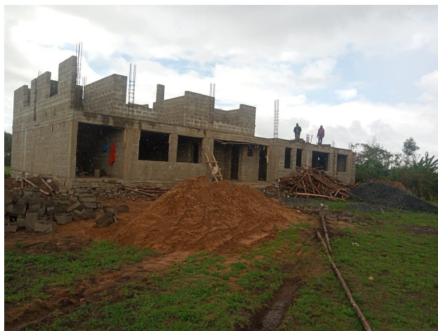
Bouw van de opvang
