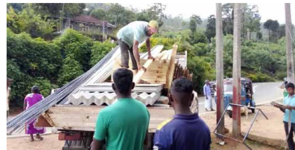
PR23-047 Aanleg waterleiding
